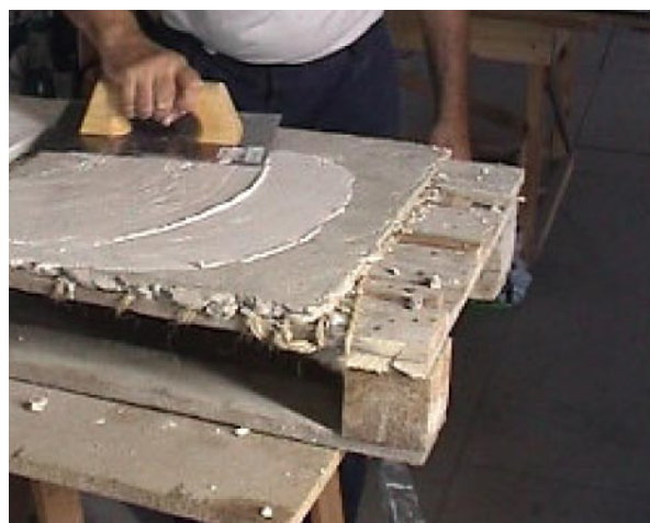
Aplicación de las capas de mortero sobre la estructura de madera.
