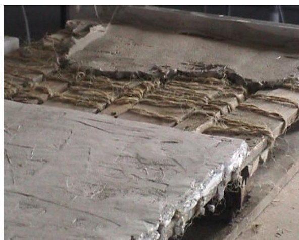
Aplicación de las capas de mortero sobre la estructura de madera.
