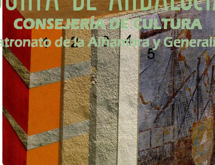
Estrato compositivo: 1. Soporte de ladrillo. 2. Mortero. 3. Segundo mortero. 4. Capa de enlucido. 5. Capa de pintura.
