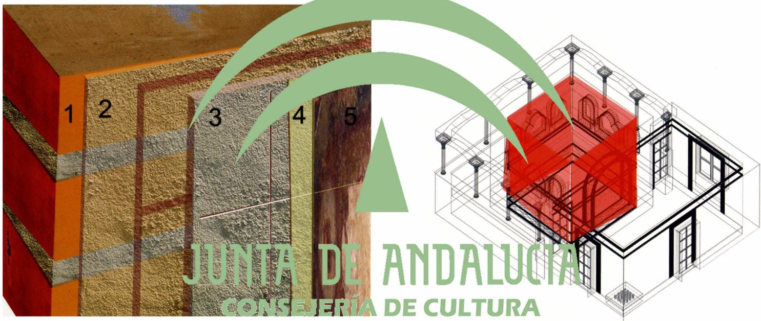
Estrato compositivo: 1. Soporte de ladrillo. 2. Mortero en donde se traza el dibujo compositivo general (sinopia). 3. Segundo mortero. 4. Capa de enlucido. 5. Capa de pintura.
