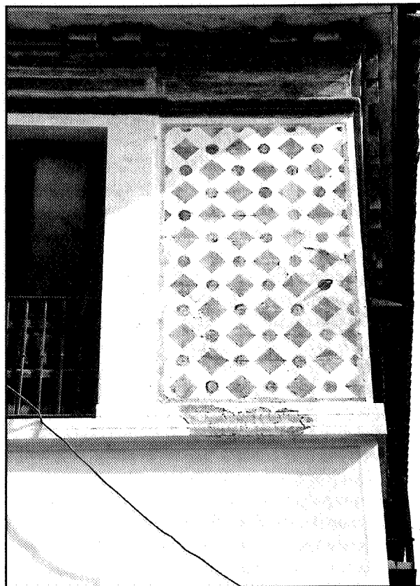
Fig. 5. Sevilla. Iglesia de Santa María la Blanca. Fachada sur. Detalle (después de la restauración).
