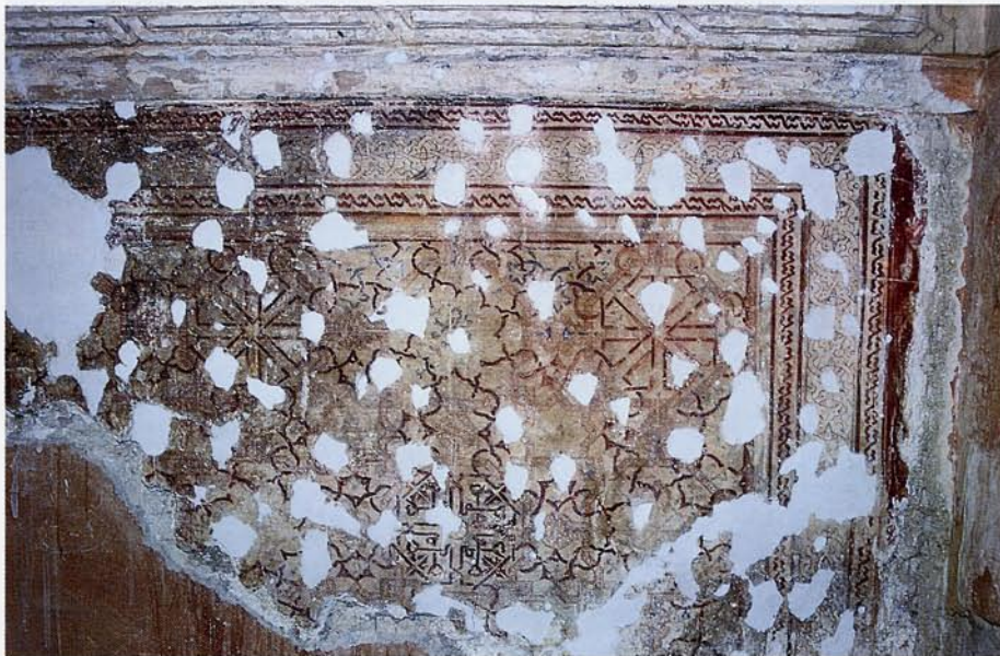
Lám. 34. Patio del Harén. Paramento A 2. Detalle después de la limpieza y del estucado.
