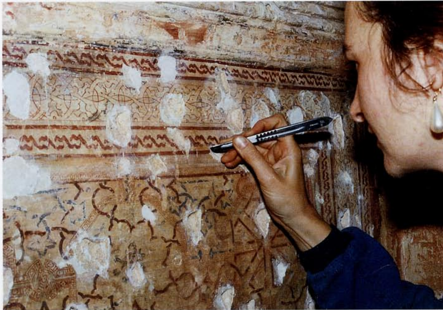
Lám. 29. Patio del Harén. Paramento A 2. Tratamiento de eliminación de repintes.
