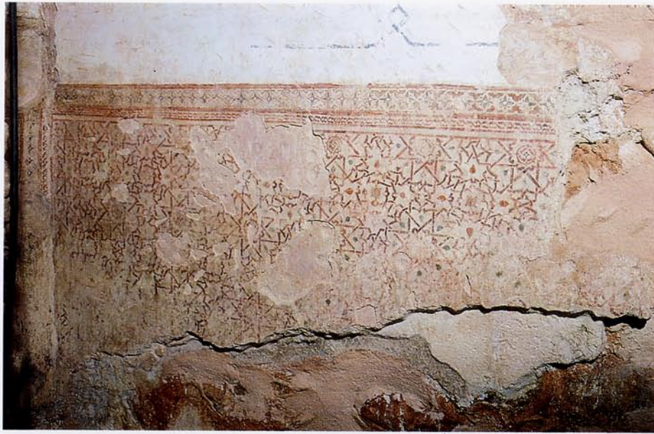
Lám. 39. Sala de la Barca. Paramento B. Fotografía final.
