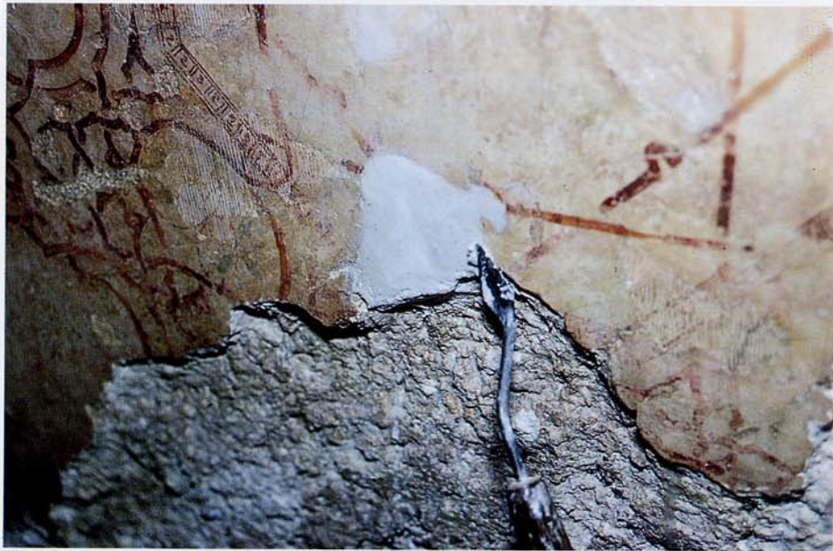
Lám. 32. Patio del Harén. Plastecido de las faltas.
