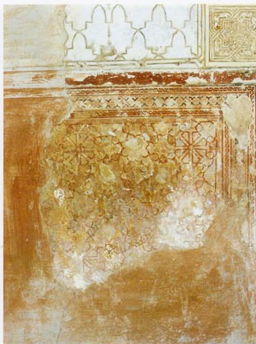
Lám. 26. Patio del Harén. Paramento A 1, antes del tratamiento. Se observan repintes y superficies erosionadas por una fuerte limpieza.
