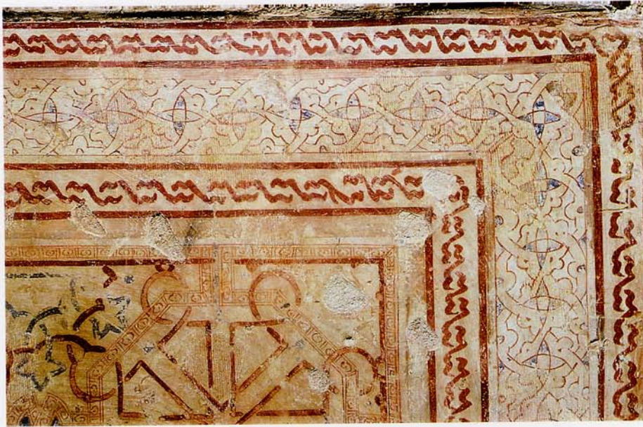
Lám. 37. Patio del Harén. Paramento A 2. Fotografía final. Detalle.
