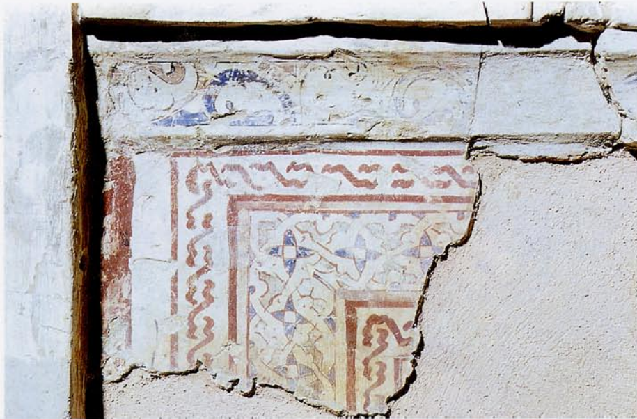
Lám. 36. Patio del Harén. Paramento A 2. Fotografía final.
