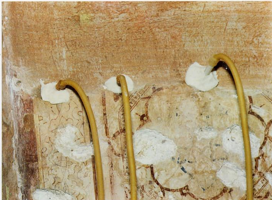
Lám. 30. Patio del Harén. Paramento A 3, después de la eliminación de repintes y consolidación de la losa de preparación por infusión.
